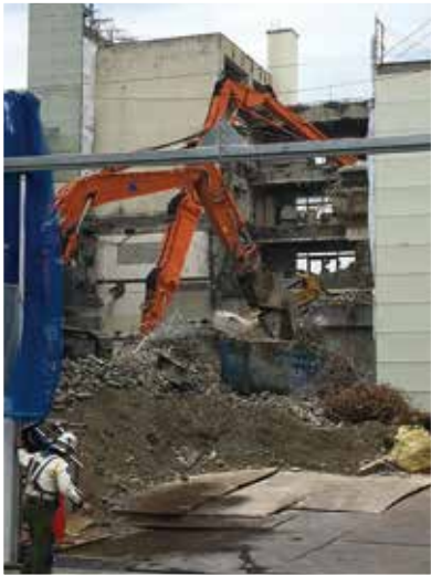
旧校舎解体工事
